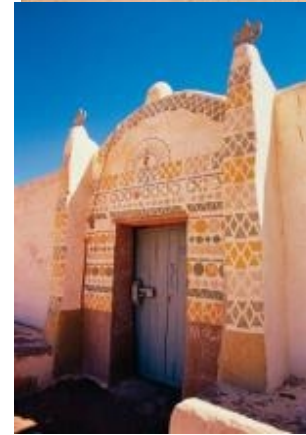
شكل ١٤، ١٥) زخارف المدخل للبيت النوبي التي تحيط بفتحة الباب وتتوج كتلة المدخل بنهايات غير منتظمة
