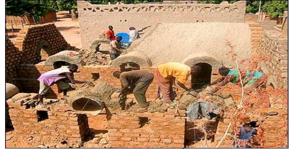
(شكل ١) اسوب بناء الأقبية في عمارة النوبة للحماية من حرارة ويغشى الطوب الني بطبقة من الطين .
